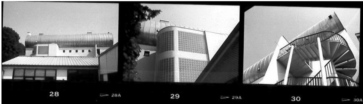
Archives Maison populaire, photos : construction du nouveau bâtiment en 1995
