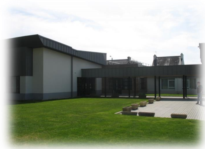
Figure 4 Des espaces de circulation entre les ailes du bâtiment.
