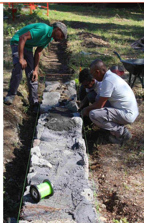
Crédit photo : ALIE (ALIE-Chantier ACI dans le cadre du programme de rénovation urbaine des Camélias)
