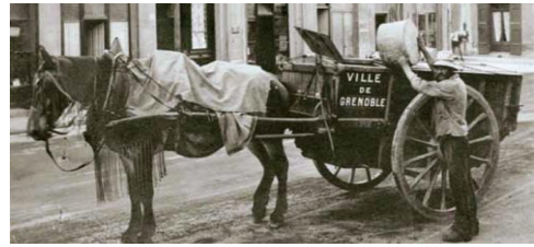
Photographie 1 : Chiffonnier de Grenoble - Source : AMORCE (s.d.)
