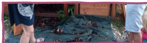
Figure 1: Installation d'une bâche étanche au sol devant les bacs de remplissage et de maturation. Source : Pistyles
