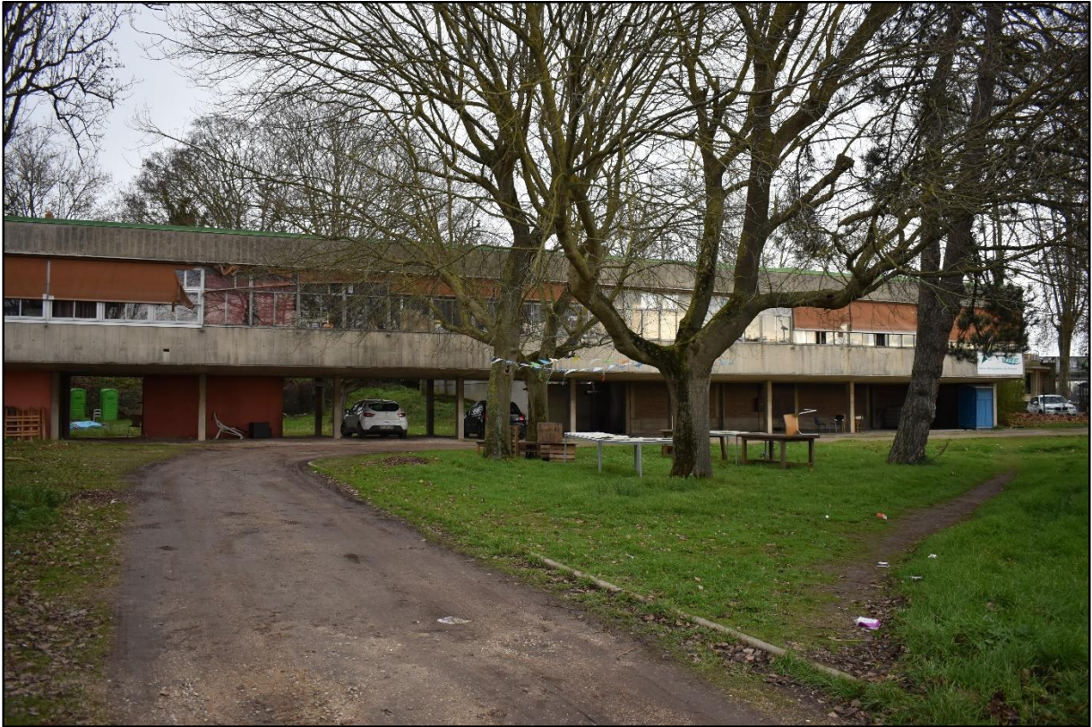
Vue d'ensemble du bâtiment, photographie prise de la grille d'entrée
